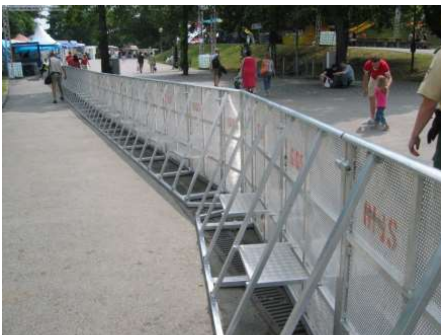
Abb. 14: Absperung innerhalb eines Stehplatzbereiches - Rückansicht
