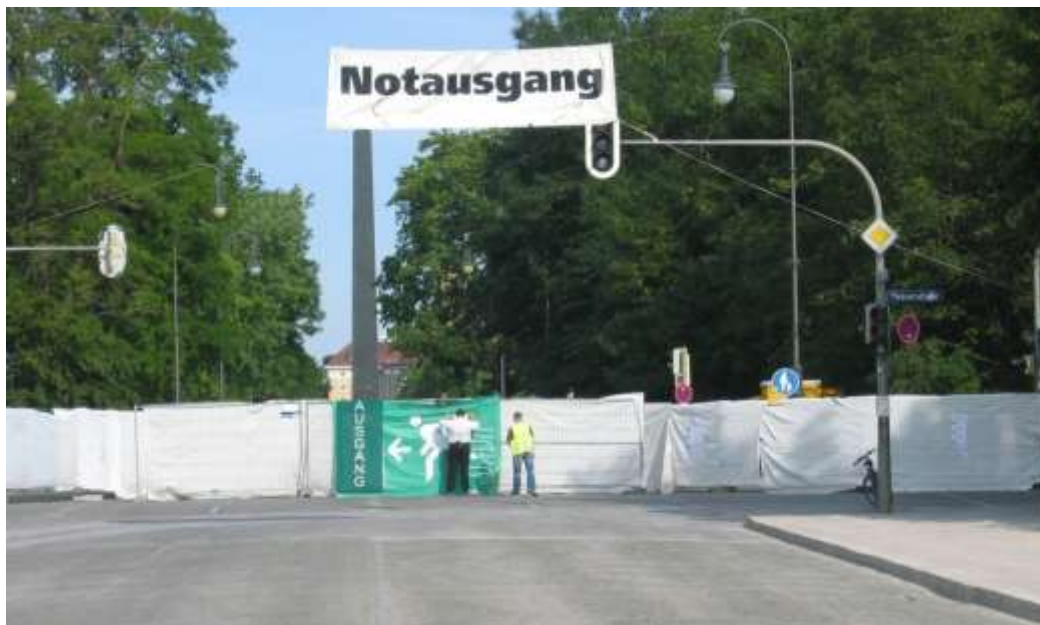
Abb. 6: Bauzaun als Sichtschutz mit Notausgangskennzeichnung; zu beachten sind mögliche Windlasten, die auf die Banner einwirken können.
