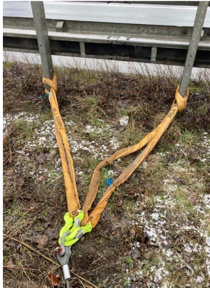
Abbildung 24: Anschlagpunkt Pfosten Schutzleitplanke
