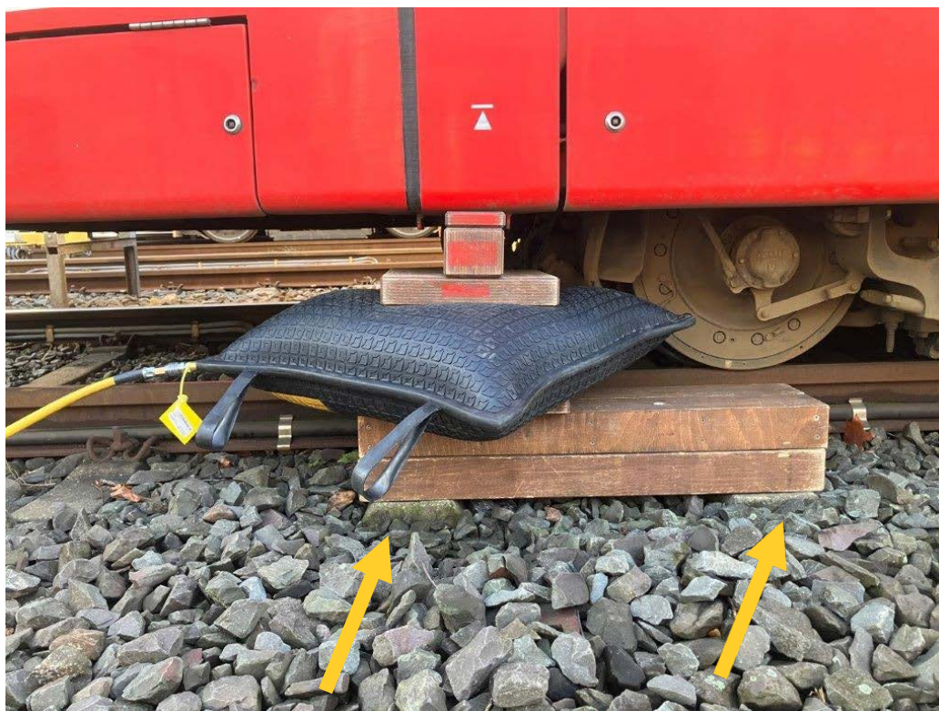
Abbildung 7: Hebekissen (8 bar) am Hebepunkt
