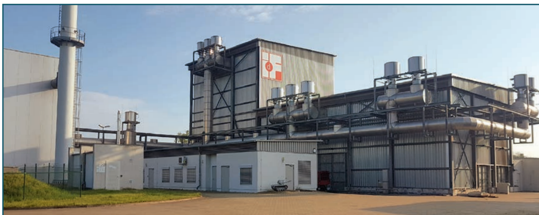
Bild 1: Brandhaus mit vier Brandräumen und Rauchgasreinigungsanlage.
