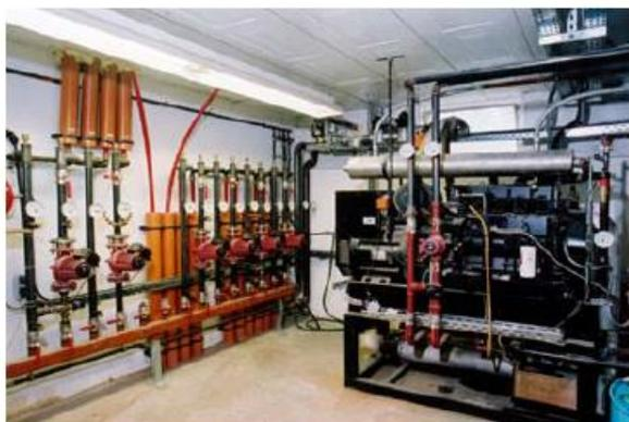
**Bild 5: Beispiel eines Blockheizkraftwerkes** [Quelle: Biogas-Nord / ENSPAR Biogas]
