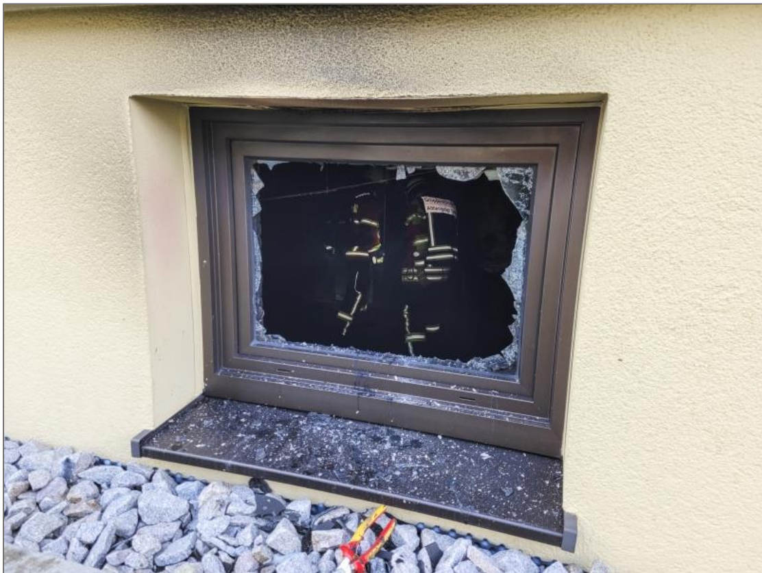
Abbildung 3: Zerberstete Fensterscheibe eines Kellers nach Explosion eines Batteriespeichers [www.feuerwehr.de (2022). Kellerbrand nach Explosion eines Batteriespeichers, http://www.feuerwehr.de/einsatz/berichte/einsatz.php?n=64488 , zuletzt aufgerufen am 21.03.2023]; mit freundlicher Genehmigung des Kreisfeuerwehrverbandes Calw.
