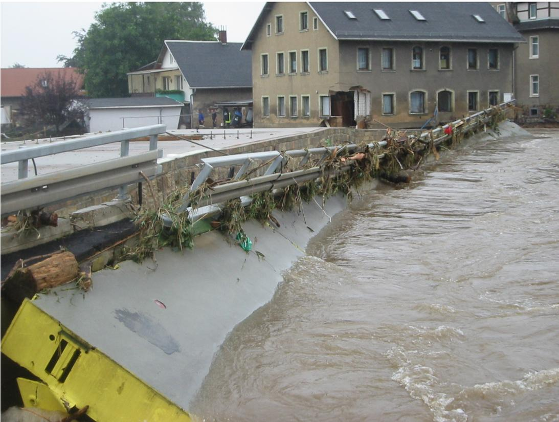
Abb. 2/1: Die Baustelle der Kirchenbrücke in Flöha wird durch Hochwasser zerstört. Es kommt u.a. durch das Umwerfen der Behelfsbrücke zu einem Wasserstau, der weite Teile des Stadtgebietes überschwemmt und erhebliche Zerstörungen verursacht. (Foto: FF Flöha)
