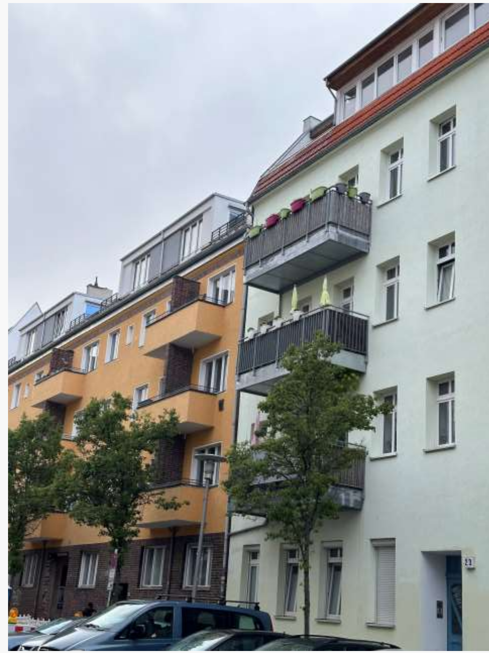
Abb. 1: Nachverdichtung durch Dachgeschossausbau
