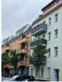
Abb. 1: Nachverdichtung durch Dachgeschossausbau
