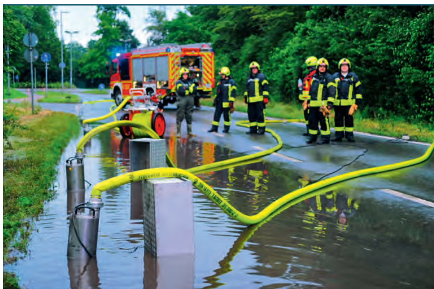
Bild 1: Konservatives Abstützen der Tauchpumpen.
