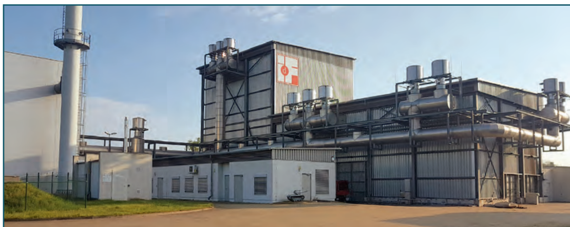
Bild 1: Brandhaus mit vier Brandräumen und Rauchgasreinigungsanlage.
